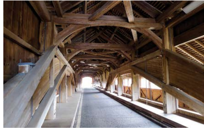
Das imposante Fachwerk der für den Autoverkehr gesperrten Reussbrücke bei Sins.
